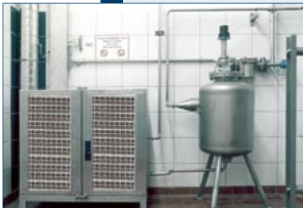
Bild 8: Komplett verplombte Messstrecke für Alkohol
