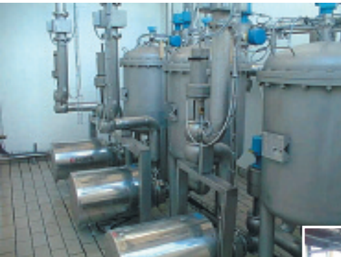
Selbst füllende Annahmeanlagen im Keller
