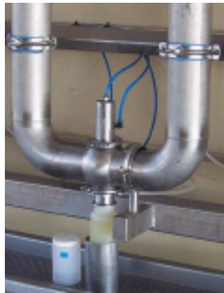
Probenehmertyp PT mit integrierter Spüleinrichtung
